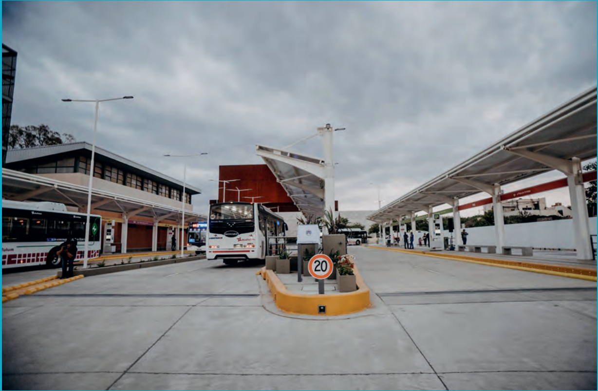
Estación de Transbordo Córdoba | RedTulum
